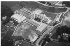
手前側のホールを内蔵する新管理棟、右奥に体育や部活動を充実させる東グラウンドが完成(昭和57年)
