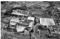
直線102m、806台収容の駐車場と近代化した東グラウンドが完成(平成23年)
