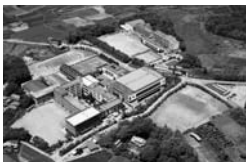
奥のグラウンドに隣接する芸術の奥深さを追求するミュージックセンターが竣工(平成3年)
